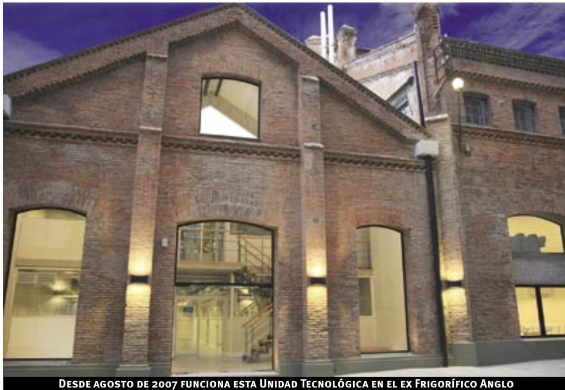
DESDE AGOSTO DE 2007 FUNCIONA ESTA UNIDAD TECNOLÓGICA EN EL EX FRIGORÍFICO ANGLO
