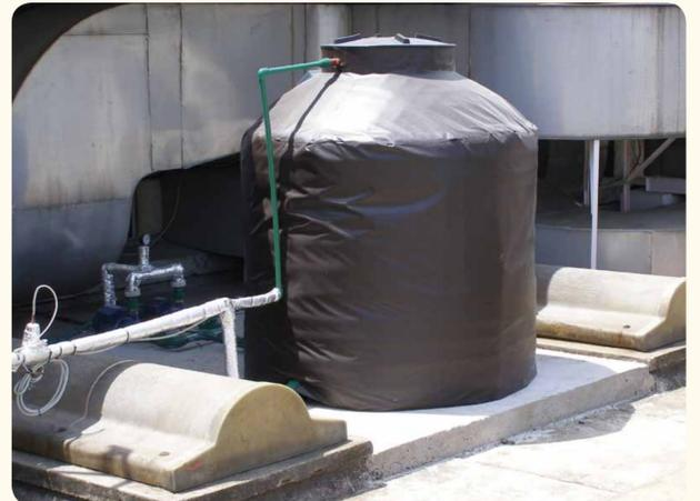
Fig. 2- Tanque acumulador de ACS de 1000 lts.
