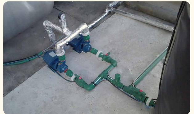
Fig. 3- Bomba(s) recirculadora(s) de agua entre los paneles y el tanque acumulador.
