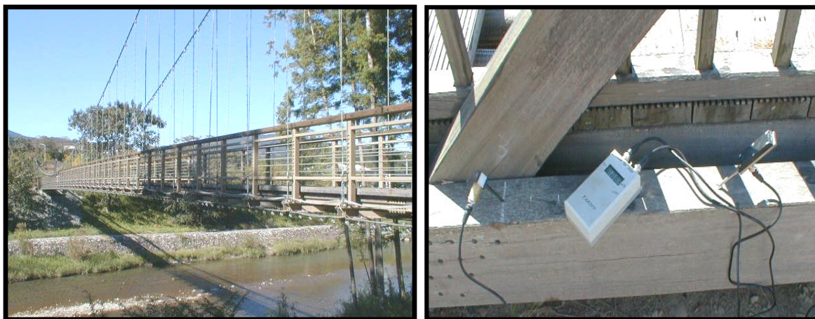
Figuras N° 4 y 5 : Evaluación madera en servicio, uso de equipo Fakopp en la estructura de un puente.
