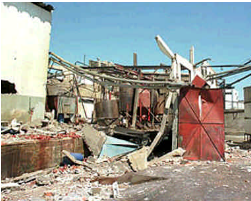
Efecto producido por la explosión de un recipiente sometido a presión con vapor (digestor de grasa).
