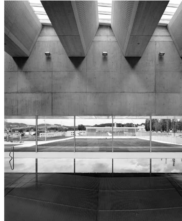
FIGURA 12. DETALLE DEL SISTEMA ESTRUCTURAL EN LA ZONA DE PISCINA DE SALTOS. FUENTE: FOTOGRAFÍA DE RASMUS NORLANDER
