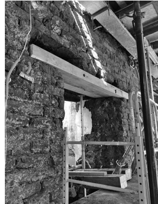
FIGURA 3. INTEGRACIÓN DE MADERA RECICLADA PARA CONSOLIDACIÓN DE DINTEL EN EJE N° 9. FUENTE: FOTOGRAFÍA DEL AUTOR DEL ARTÍCULO
