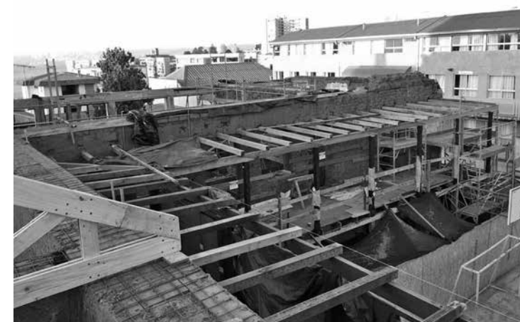
FIGURA 6. IMAGEN QUE MUESTRA LAS RECONSTRUCCIONES PARCIALES Y EL RESCATE DE ESTRUCTURAS DE MUROS, ENTREPOSOS Y TECHUMBRES. FUENTE: FOTOGRAFÍA DEL AUTOR DEL ARTÍCULO
