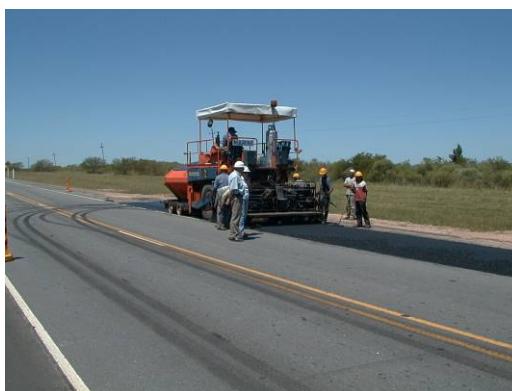
Figura 3. Colocación de carpeta asfáltica
