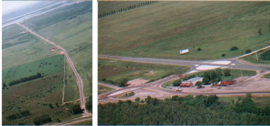
Figura 1. Vista aérea de la Obra
