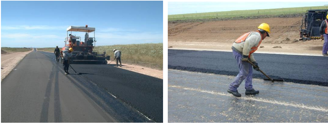
Figura 7. Compactación de carpeta asfáltica
