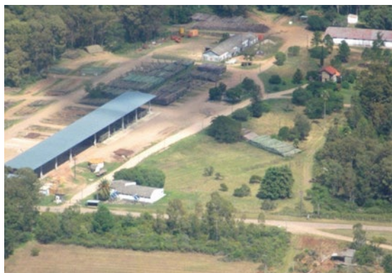
Figura 3. Vista aérea de planta de impregnación de Rincón del Bonete
