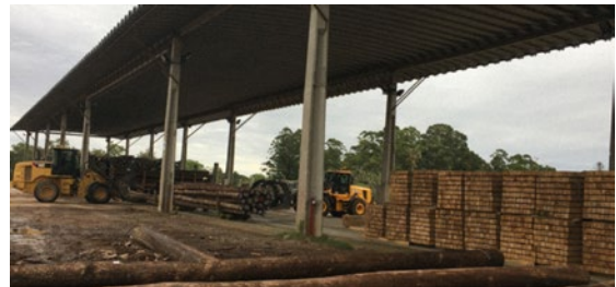
Figura 4. Cargadores frontales operando en la carga de vagonetas antes de la impregnación.
