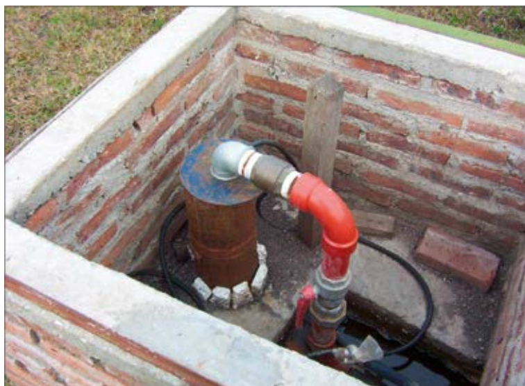
2. Pozo bien construido
