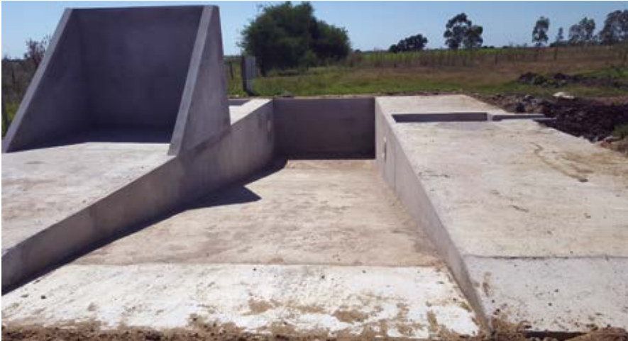
6. Desarenador en rampa
