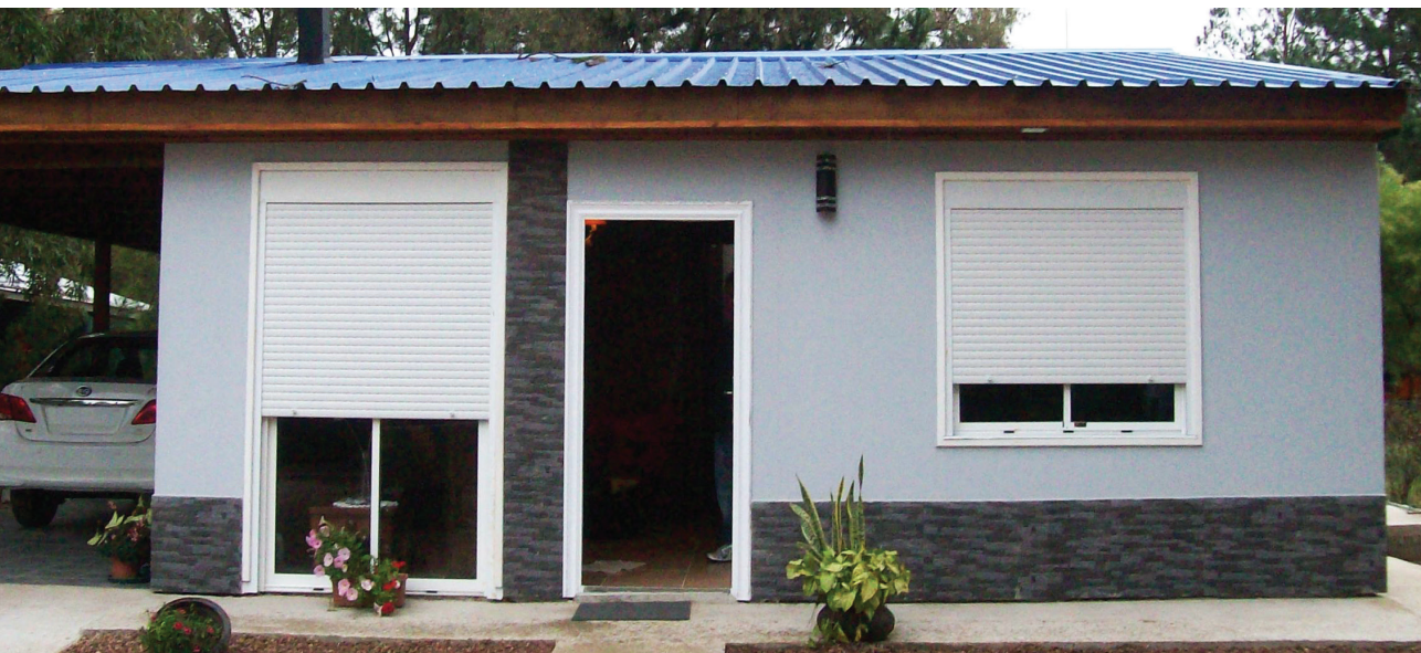
Vivienda prefabricada en madera construida con el kit desarrollado por la Carpintería Ahlers de Salto. Carmelo, 2014. Fotografía: Departamento Gestión y Transferencia Tecnológica para el Desarrollo Local del LATU.
