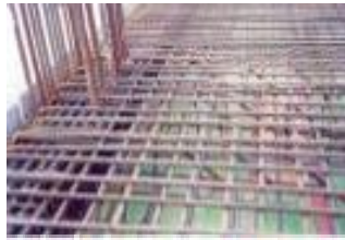
Fig. 7 Armaduras colocadas en una estructura.
